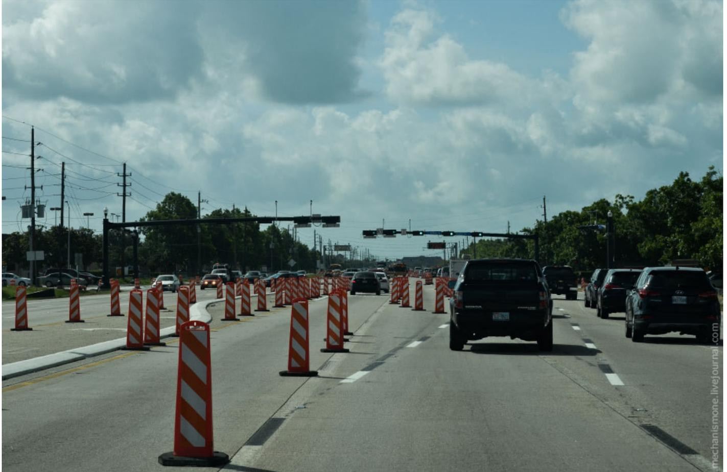
13. Чаще всего DOT хитрит, и ремонтирует или строит участки полосами, сначала делают в одну сторону дороги, сдвигая все полосы в другую сторону, а потом пускает поток на построенную дорогу, занимая обочину и середину дороги, и начинает возиться с другой старой дорогой.
