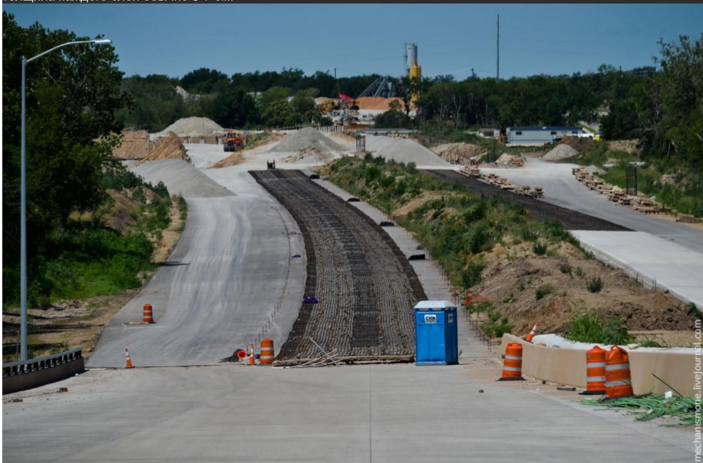
22. Зачем под бетон укладывают асфальт? Для этого есть несколько причин. Во-первых бетон хрупкий к провалам, и в случае просадки земли сразу появятся трещины, а как я упомянул выше, отремонтировать бетон не так просто. Причина, вызывающая просадку земли - это вода. Укладывая слой плотного асфальта под бетон,
