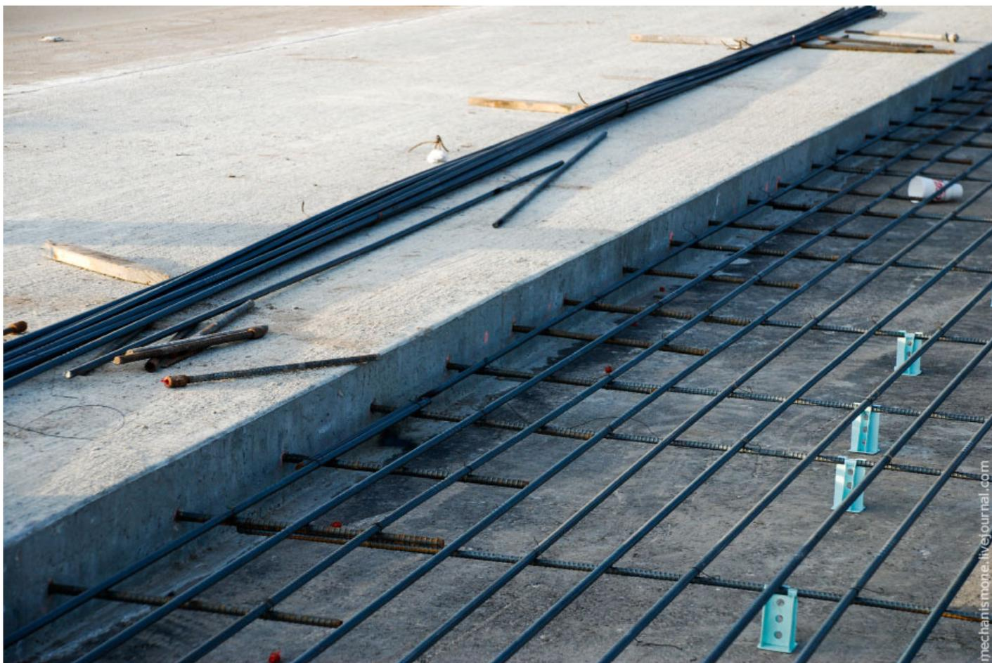
24. После всех этих заморочек, наконец начинается монтаж арматуры для бетонного полотна. Обычно используют стандартную стальную арматуру диаметром 16 мм (413 МПа). После сбора арматуры на земле, ее поднимают на пластмассовые или металлические подставки. Идеальное положение арматуры - между  $1/3$  и  $1/2$  толщины стяжки от верхнего края, иными словами - чуть выше середины стяжки.
