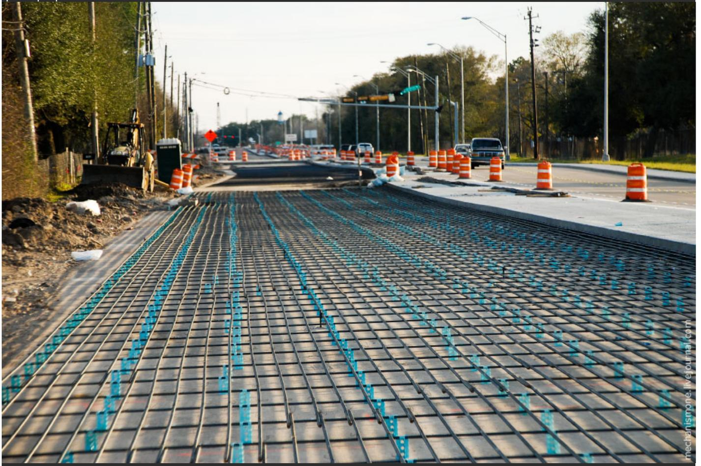
27. Арматура в бетон используется для распределения нагрузки и предотвращения появления трещин в покрытии. Процент стали в поперечном сечении (перпендикулярно ходу автомобилей) обычно 0.60%, в продольном (по ходу движения автомобилей) - 0.85%.
