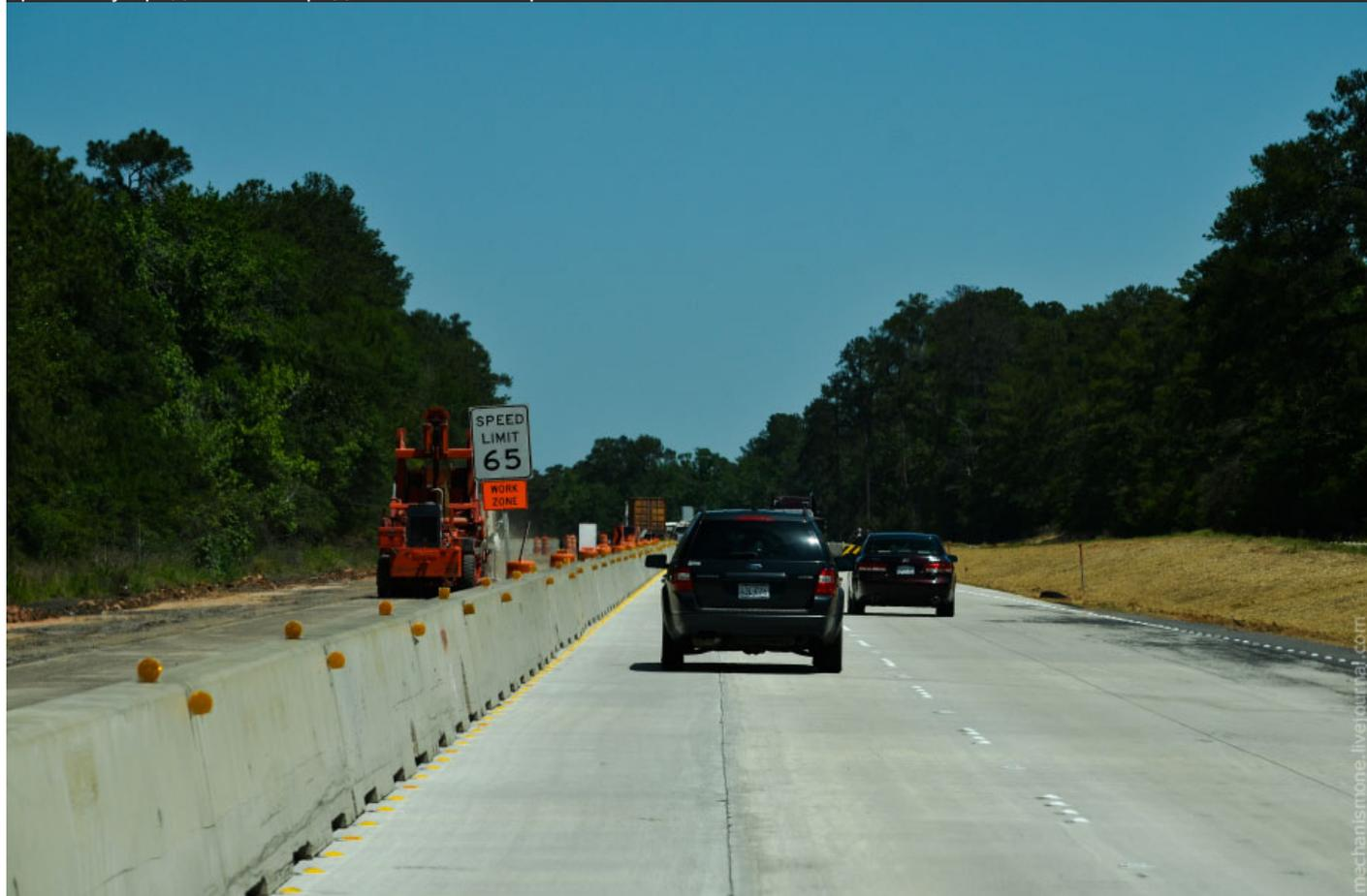
15. Так же замечу, что строители не забывают про разметку, выполняется она в виде временных "пипок" наклеенных на дорожное полотно, такие пипки отлично видны ночью (очень часто в ремонтных зонах нет освещения, т.к. столбы еще не установлены), а так же чувствуются колесом, при наезде, давая знать водителю, что он заезвался.
